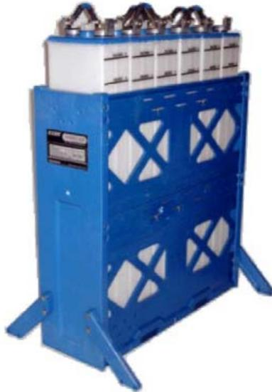
Figura 2.3: Banco de baterias chumbo-ácido com seis células em série.
