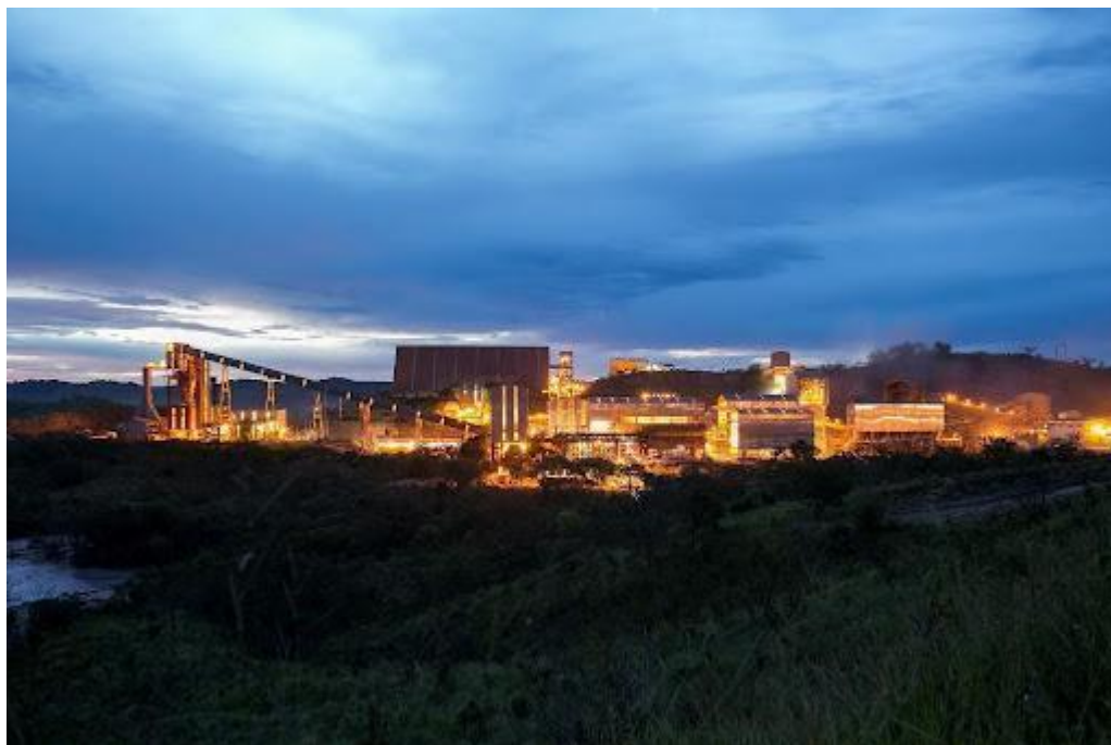
Figura 8 - Unidade de Vazante
