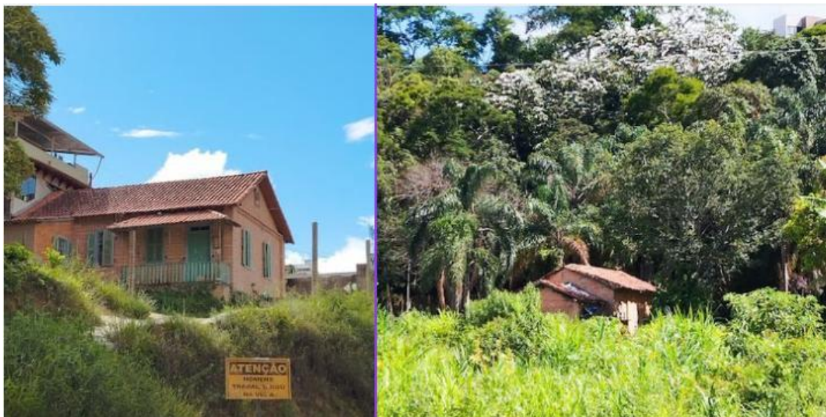
Figura 9: Edificações remanescentes da Colônia de Cima
