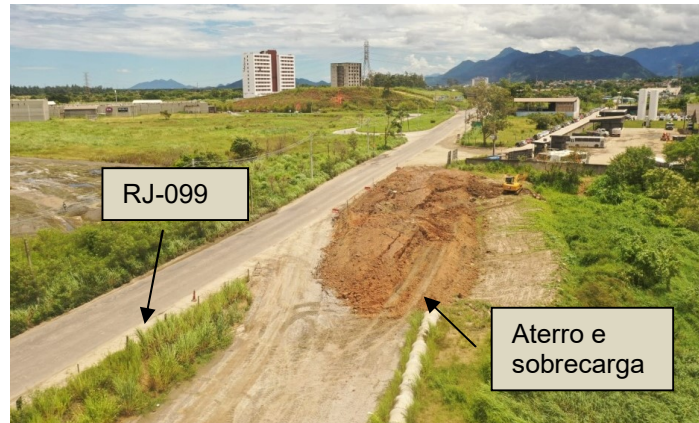
Figura 24 – Vista do aterro e sobrecarga (RJ-099)
