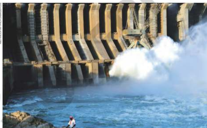
Barragem da Usina Hidrelétrica de Méroe, no norte do Sudão. Fotografia de 2009.
