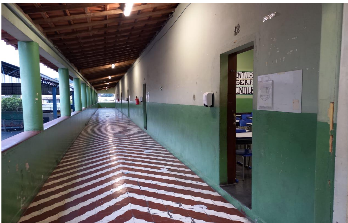
Figura 9 - Corredor das salas de aula 1º andar
