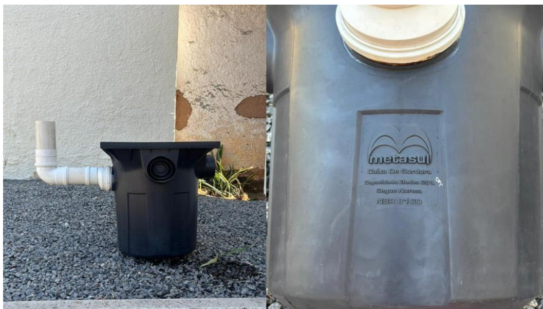
Figura 10 - Caixa de gordura utilizada para a separação da fração lipídica do soro ácido antes de sua aplicação no SAC
