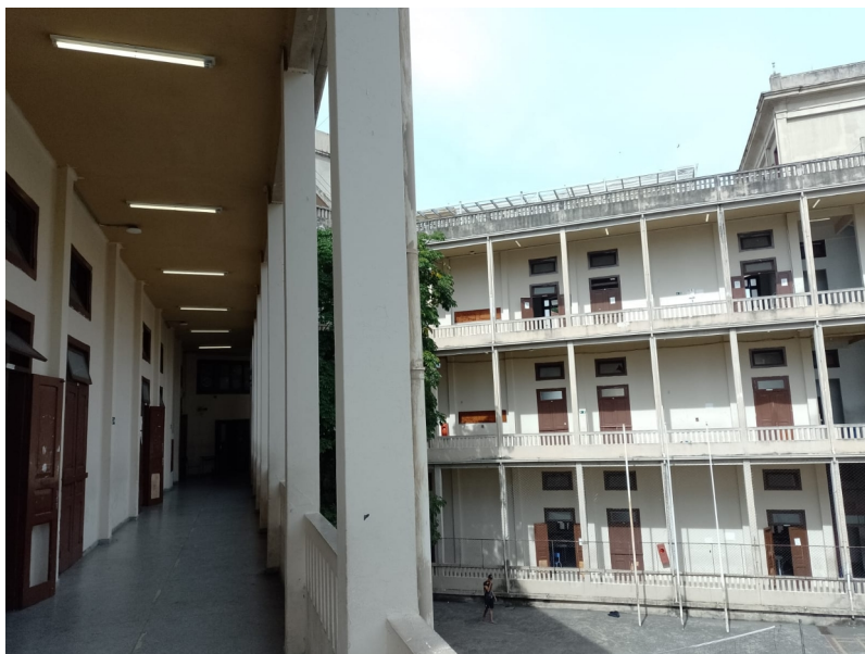
Fotografia 7 – Corredor do 2º andar das salas de aula IEE/JF
