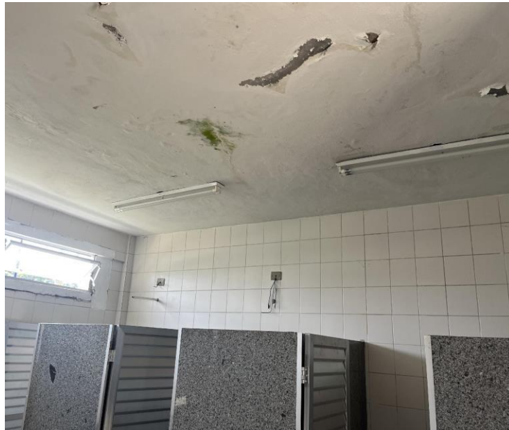
Figura 9 – Vista de um Banheiro da EE Geração
