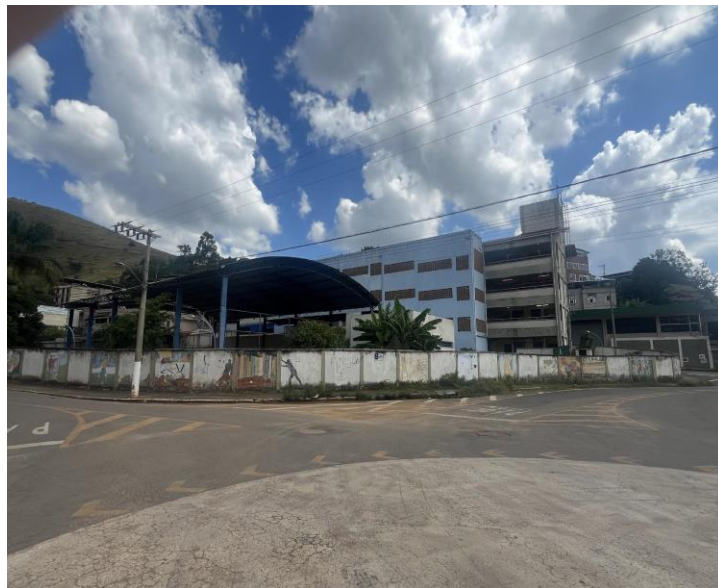
Figura 11 – Vista do Muro da Escola Estadual Geração Z
