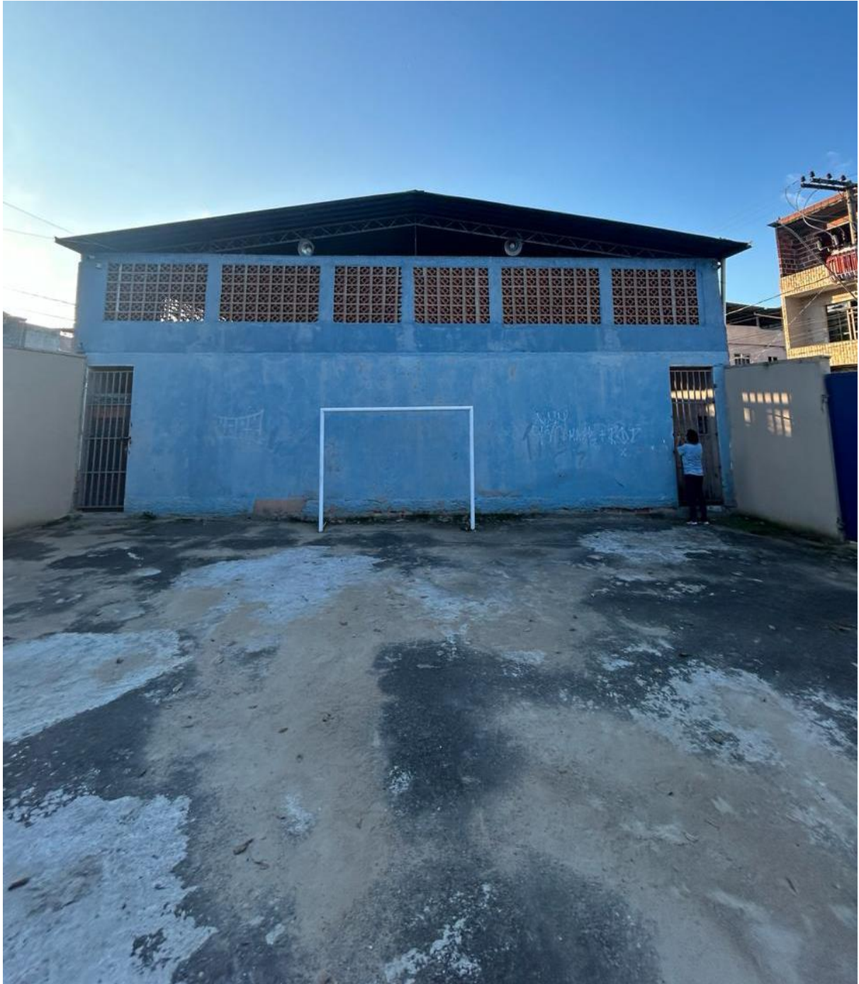
Imagem 1 – Vista exterior do anfiteatro da escola
